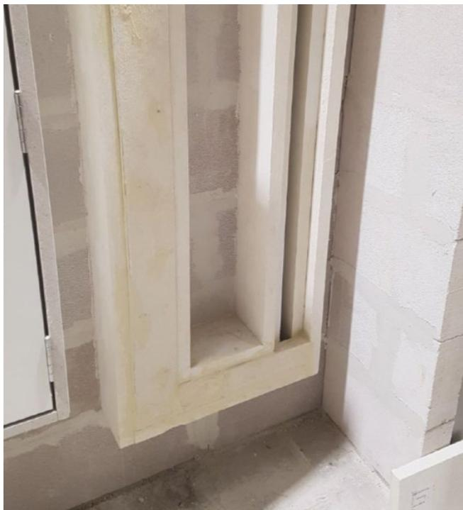
Bild 9: L90/EI90 Lüftungskanal (geöffnet)
