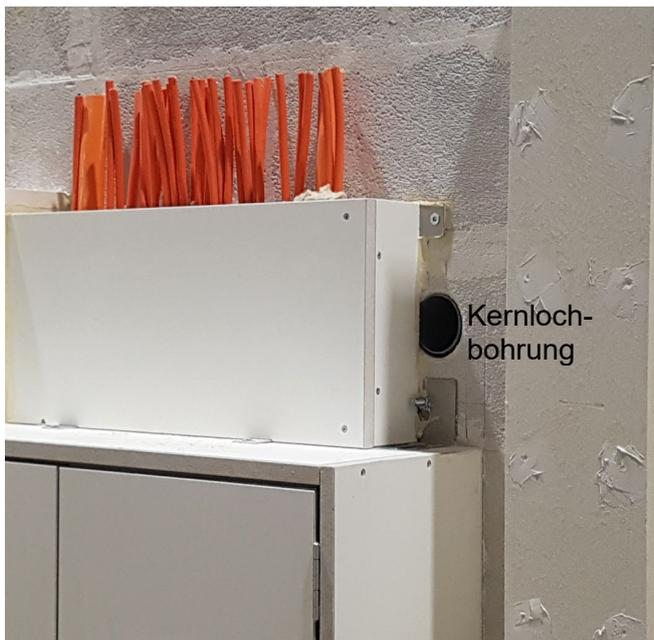
Bild 7: Kernlochbohrung durch die feuerbeständige Wand als Zu- und Abluftöffnung
